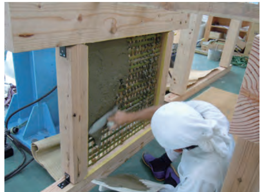
写真3 壁試験体に壁土を塗っている様子
