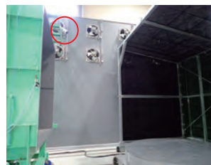
写真3 吹出口上部に設置
