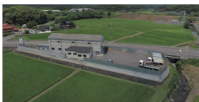
写真1 有限会社オーテック(第二作業所)
