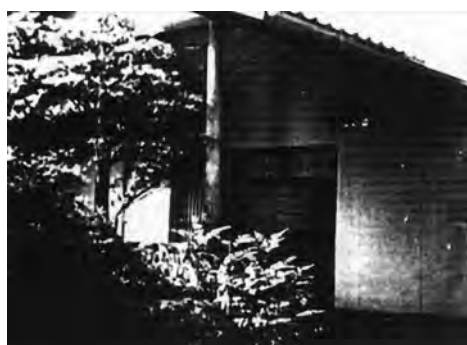
図19-15 割烹「吉野」(1950/S25年) 塗装下地に石膏ボード使用。
