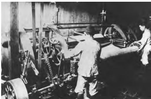
図20-1 浅野式ロータリーレース
