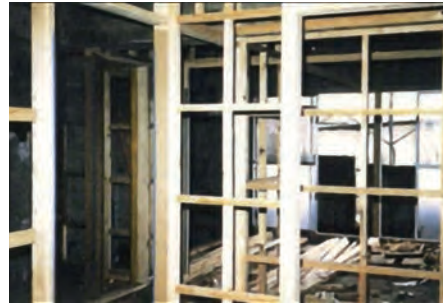
図20-10 木造軸組み間仕切壁
