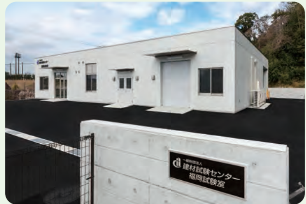
福岡試験室外観
