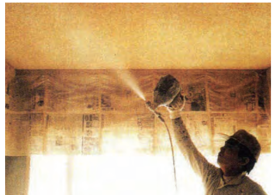
図20-13 ひる石吹付け構法
