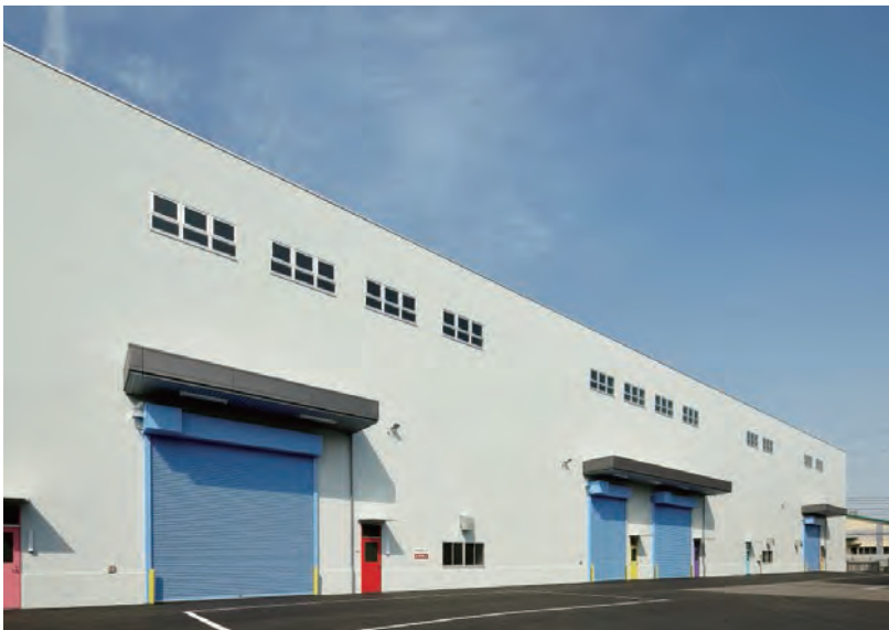
新防耐火試験棟
