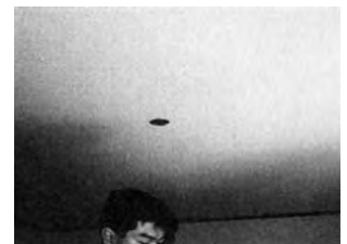
図20-15 膜天井(修繕後)
