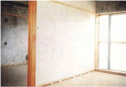
図20-9 ユニットパネル構法
