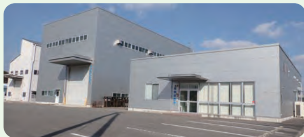
写真1 構造試験棟（写真左）及び材料試験棟（写真右）
