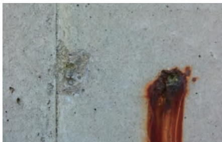
写真7 骨材に起因するポップアウトと錆汁
