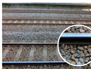
写真2 鉄道の道床に敷かれた碎石
