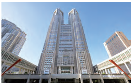
写真6 人工軽量骨材を床スラブに用いた都庁 （東京都提供）
