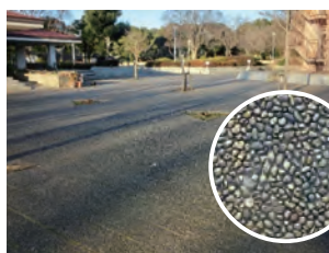
写真3 公園に敷かれた敷石の表面の豆砂利
