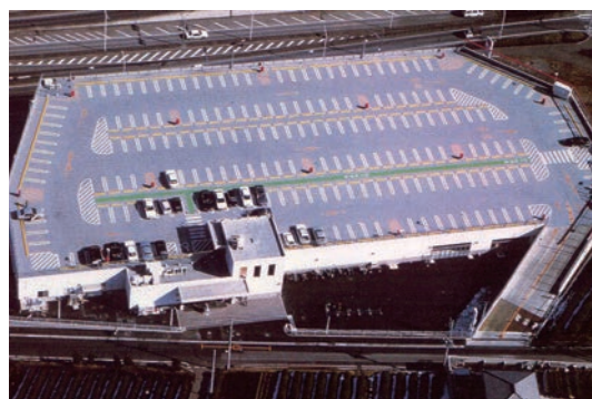
写真2 屋上駐車場の全景 (右側のランプから屋上に上がる。)
