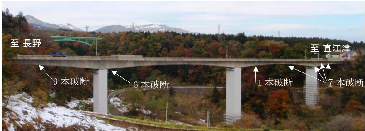
図12 妙高大橋の全景とPC鋼材破断箇所(2018年)
