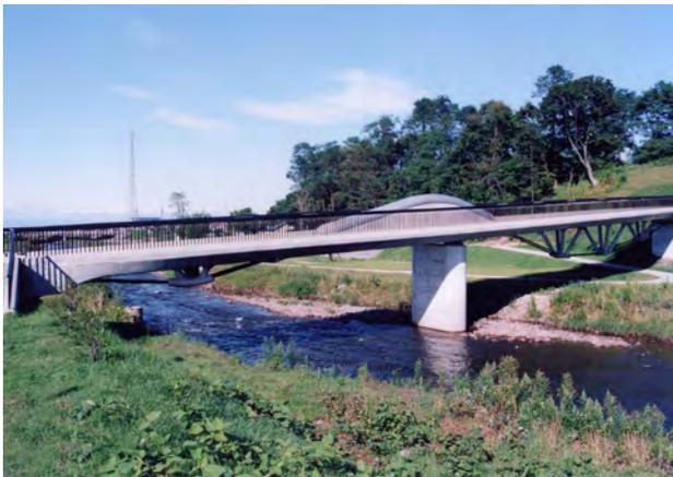
図11 完成した大偏心外ケーブルPC橋の全景
