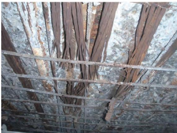
図15 下床版において9本のPC鋼材が破断<sup>10)</sup>
