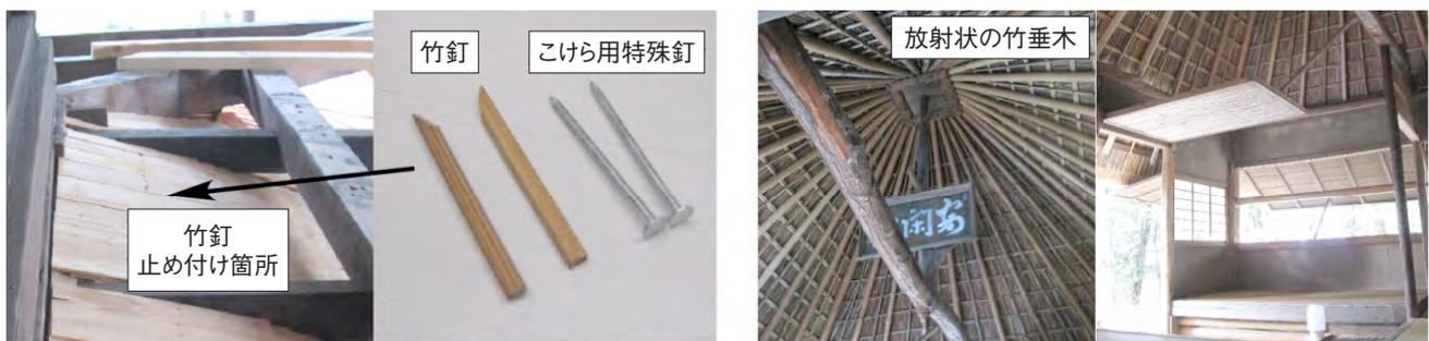
銀閣寺・平成大改修時の柿葺き止め付けに使用した竹釘
