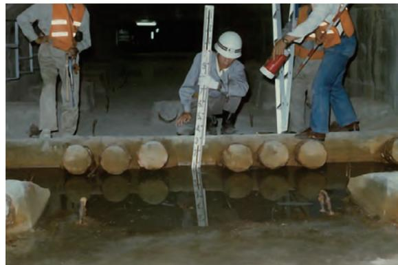
図14 箱桁内の滞水<sup>10)</sup>
