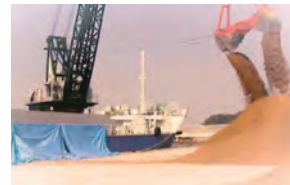
写真7 バケットによる荷揚げ
