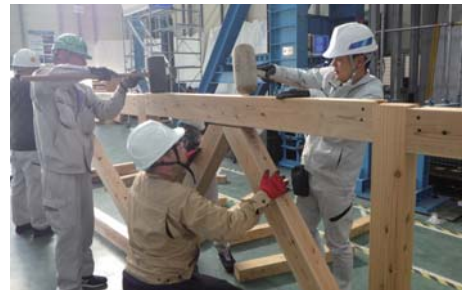
写真3 各チームによる施工状況
