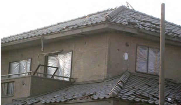
写真1 強風による開口部被害(筆者撮影)
