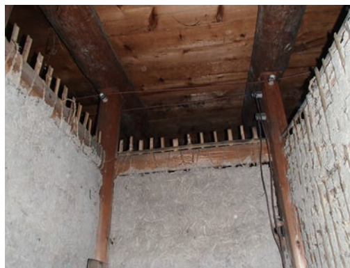
(b) 壁上部に梁がない土壁
