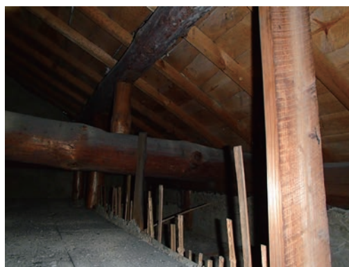
(a) 天井裏の壁土が塗り込まれていない土壁
