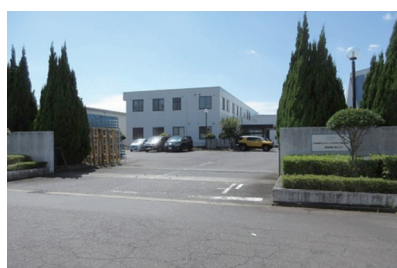
写真1 日本板硝子ビルディングプロダクツ 外観
