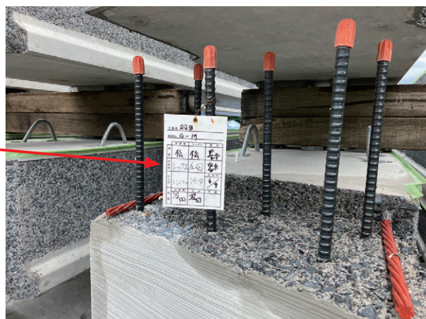
写真8 道路橋用橋げたの管理状況（カンパシット）
