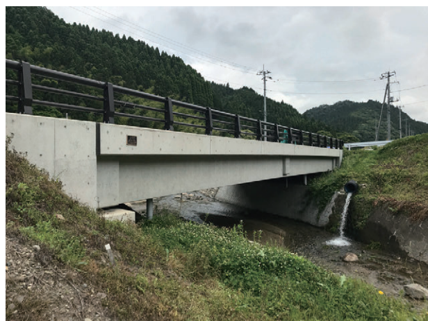
写真10 FA桁による道路橋行屋橋（那須町大畑）
