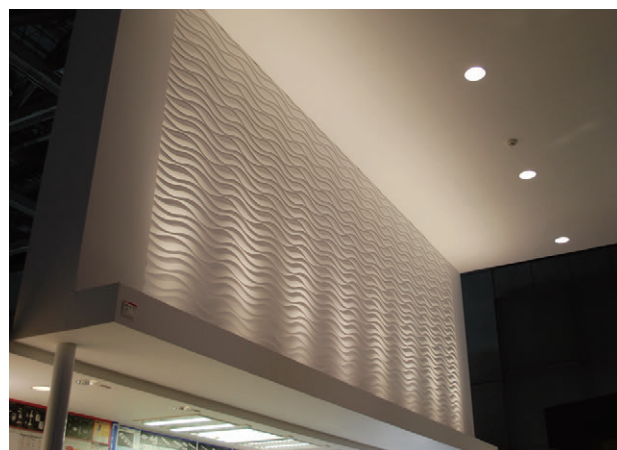
写真6 けい酸カルシウム 不燃内装材の施工例
