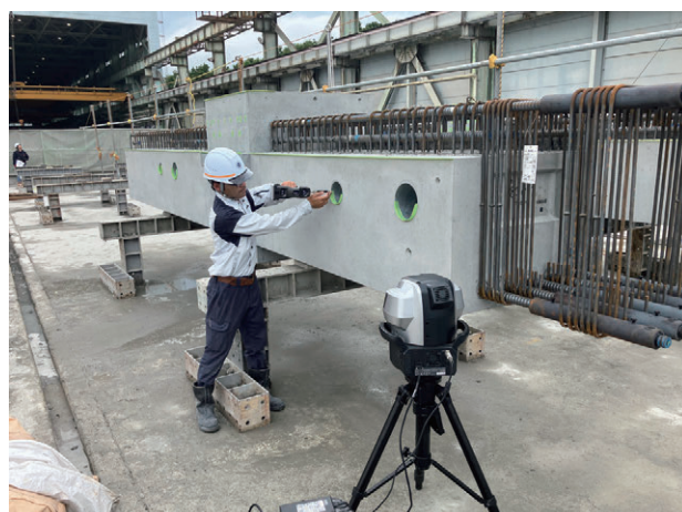
写真13 3次元測定機による出来形測定状況
