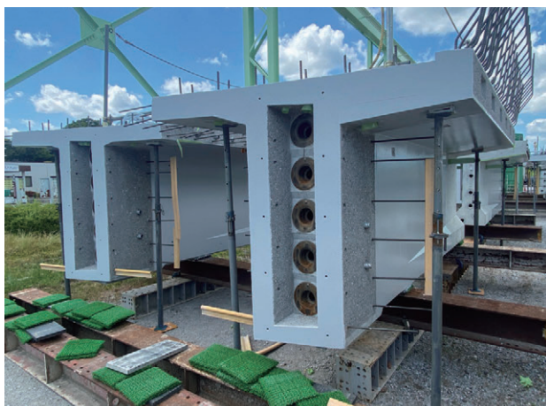
写真5 耐塩害仕様橋げたの一例
