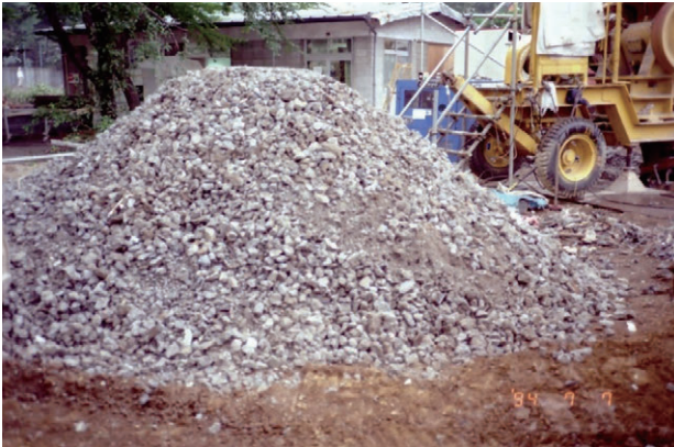
写真2 小割りにされたコンクリート塊
