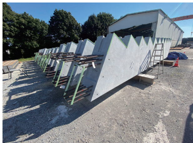
写真6 総合競技場で使用されたPCa製品の一例
