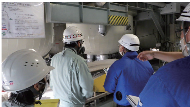
写真10 JIS認証維持審査時の工場巡回状況
