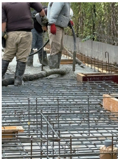
写真1 生コンの打設状況
