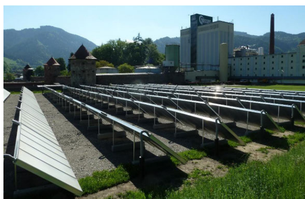
写真1 Austria Goess にあるハイネケン工場の集熱器 (1,500m 2 )
