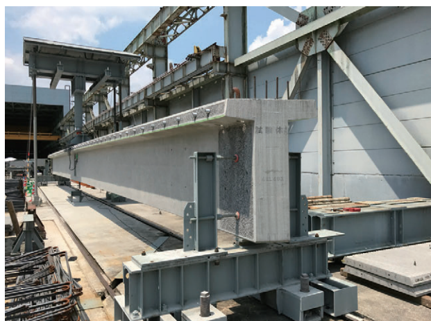
写真9 FA桁の耐荷重試験状況
