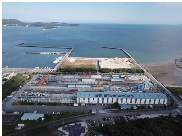
写真2 川田建設株式会社 九州工場
