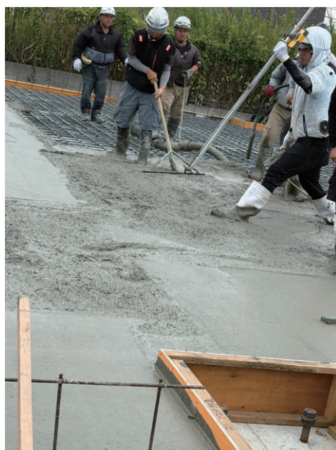
写真2 生コンの打設状況
