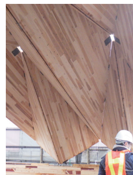
写真6 実大折版屋根モックアップの内側から
