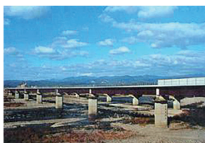
写真1 人工軽量骨材を床板に用いた雄物川の橋梁 (ALA協会提供)
