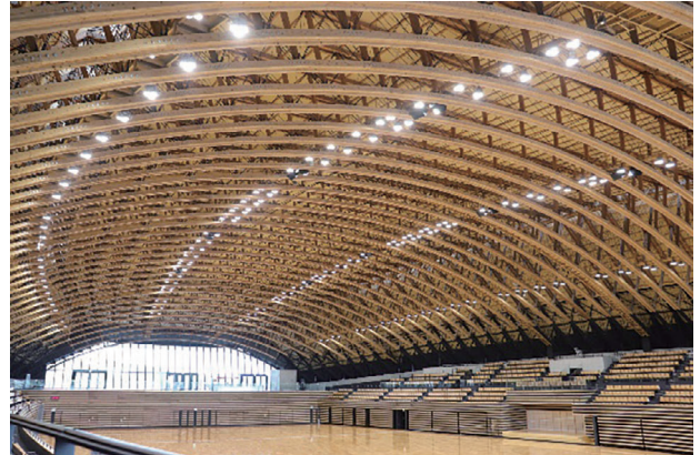
写真4 大分県立武道スポーツセンターの内部
