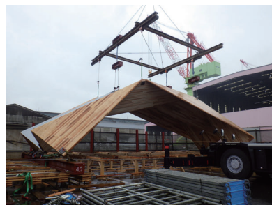
写真5 実大折版屋根モックアップのハングアップ試験
