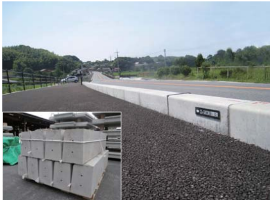
写真3 歩車道境界ブロックへの適用例
