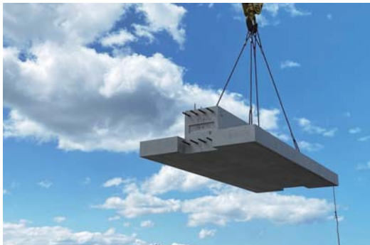
写真2 CUCO-建築用プレキャスト部材の施工状況(1)
