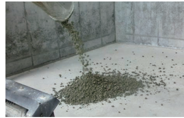
写真29 アジテータトラックからの粒状化再生骨材の排出
