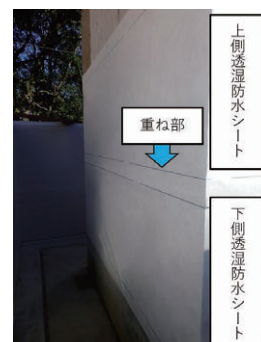
図3及び写真1 両面プチルテープの施工方法
