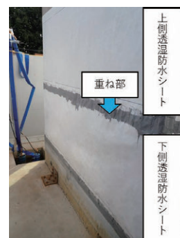
図4及び写真2 接着剤の施工方法
