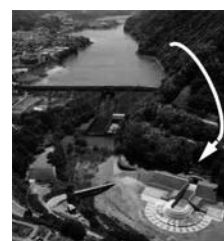
写真12 排砂バイパスの例(文献18より)
