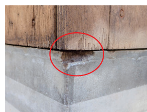
写真25 基礎隅角部の凹凸
