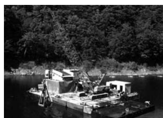
写真11 ダム堆砂の浚渫の例 (文献18より)
