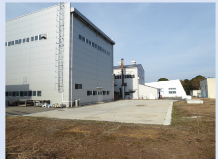
屋外施工スペース（10m×26m）
