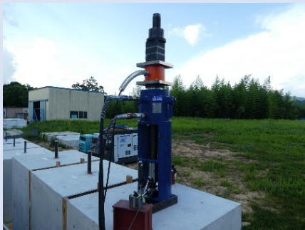
長尺アンカーの引張試験
