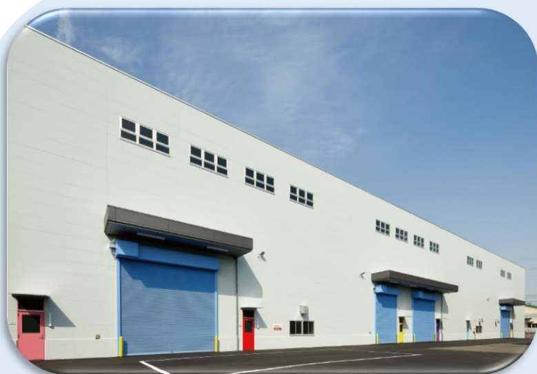
新防耐火試験棟
