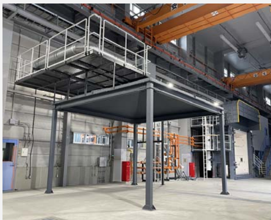
多目的試験場
