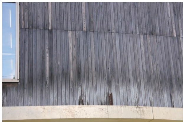
写真1 10年程度経過した木質の外装材
