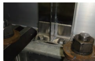
写真8 損傷状況 ・中柱脚部補強リブの変形
